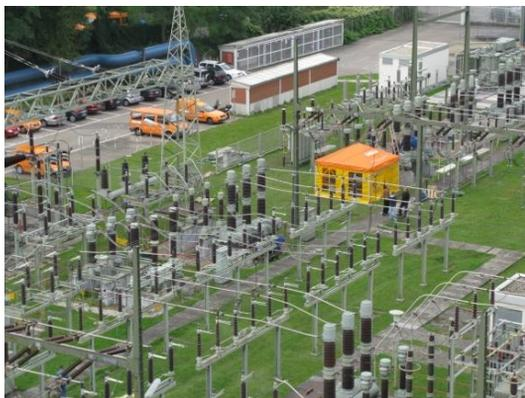
Nach Abschluss der Vorarbeiten begann Ende 2012 der eigentliche technische Neubau der Anlage. Ziel des Projektes war, die bestehende 110-kV-Freiluftschaltanlage komplett als SF6-gasisolierte Innenraumschaltanlage zu erneuern und im neuen Schaltanlagegebäude in Betrieb zu nehmen.
