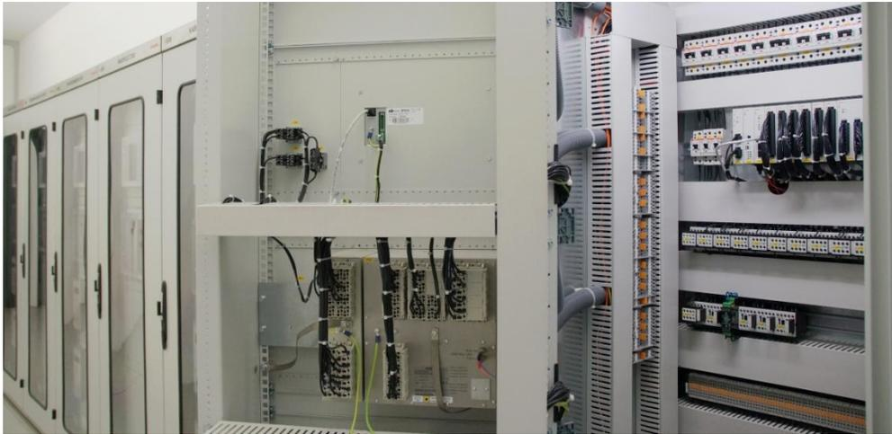
Das „n-1-Prinzip“ wurde beim UW West konsequent durch den Aufbau redundanter Systeme umgesetzt. Dieses Prinzip besagt, dass eine Komponente ausfallen darf, ohne dass die Versorgung mit elektrischer Energie eingeschränkt wird.
